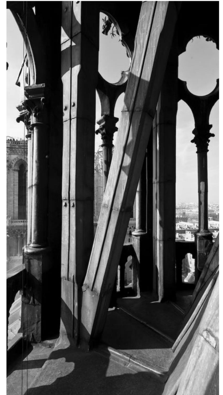
Photo prise de l'intérieur de la flèche vers l'extérieur. La structure en bois de la charoente de la flèche est entièrement recouverte de plomb.
