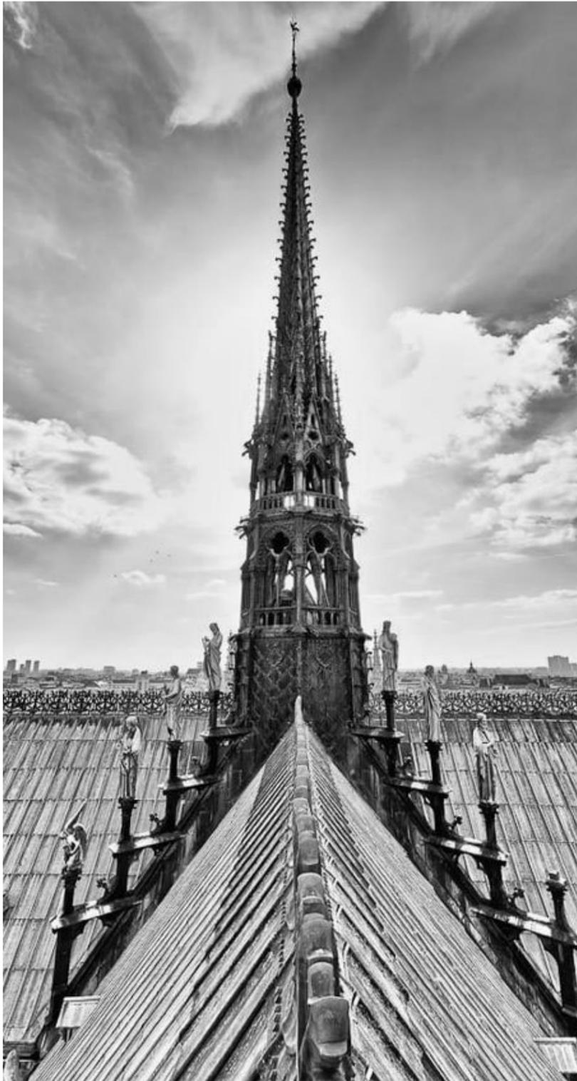
Photo de la toiture de Notre-Dame en plomb, recouvrant la charpente de la croisée des transepts et la charpente de la flèche
